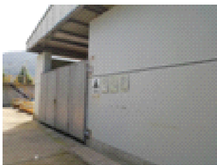
危险废物贮存场所
