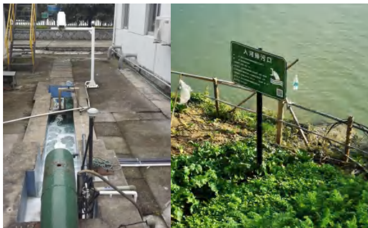
图 3.2.2.2-6 污水站出水及废水外排口
